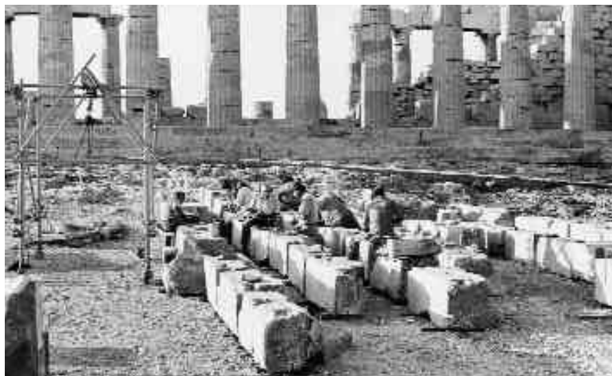
Συντηρώντας τους αποσυναρμολογημένους λίθους του Ν. τοίχου του Ερεχθείου το 1980
