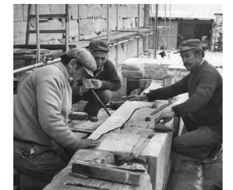
Ο Ν. Σκαρής (δεξιά), ο Γ. Σινάνης και ο Μ. Σκαρής συμπληρώνοντας με νέο μάρμαρο τους λίθους του Ν. τοίχου του Ερεχθείου το 1982
