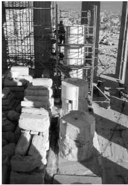
Εργασίες αποκατάστασης στον Πρόναο τον Οκτώβριο του 2000. Φωτ. Α. Λαμπρινού
