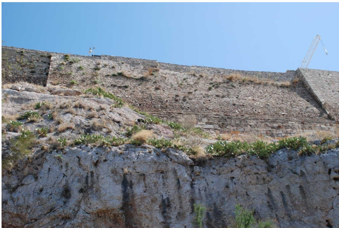
Εικ. 3 Άποψη Τείχους και βραχώδους πρανούς (νότιο τμήμα, Μάιος 2016).
