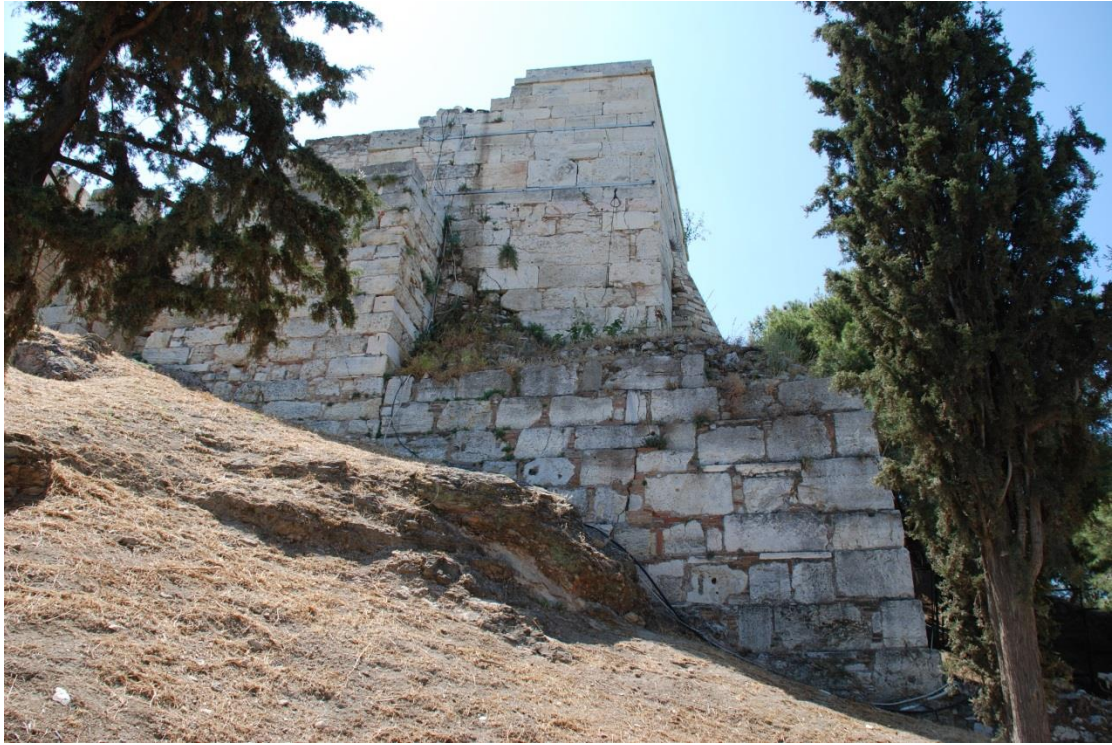
Εικ. 9 Άποψη Τείχους (δυτικό τμήμα-περιοχή πύλης Βευλέ).
