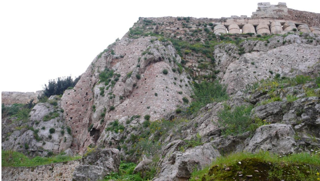
Εικ. 5 Άποψη Τείχους και βραχώδους πρανούς (βόρειο τμήμα).
