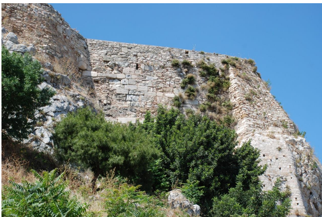
Εικ. 4 Άποψη Τείχους και βραχώδους πρανούς (βόρειο τμήμα, Μάιος 2016).
