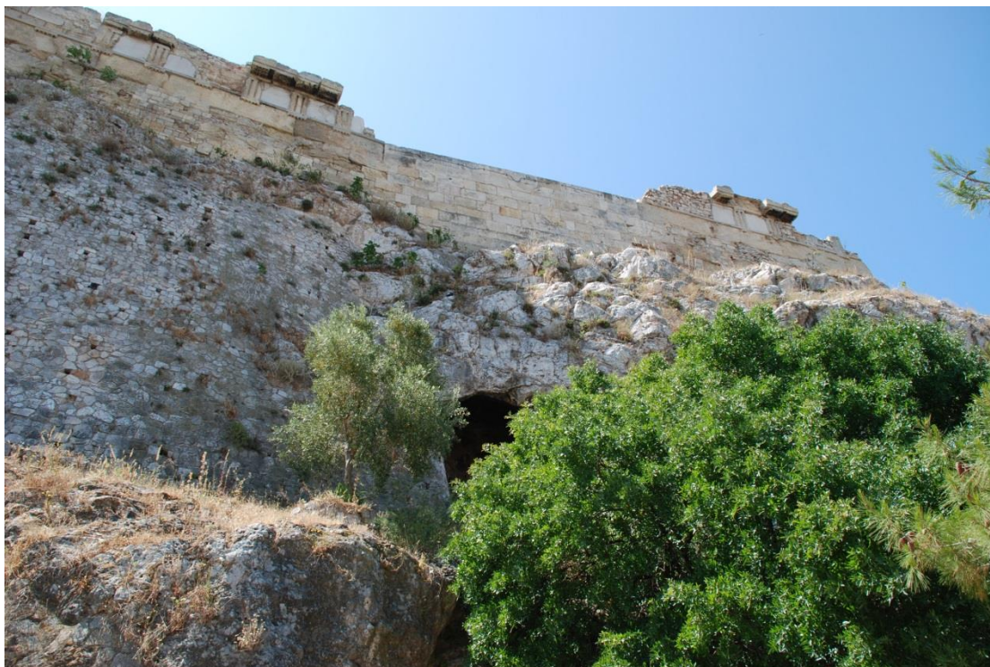
Εικ. 7 Άποψη Τείχους και βραχώδους πρανούς (βόρειο τμήμα, Μάιος 2016).
