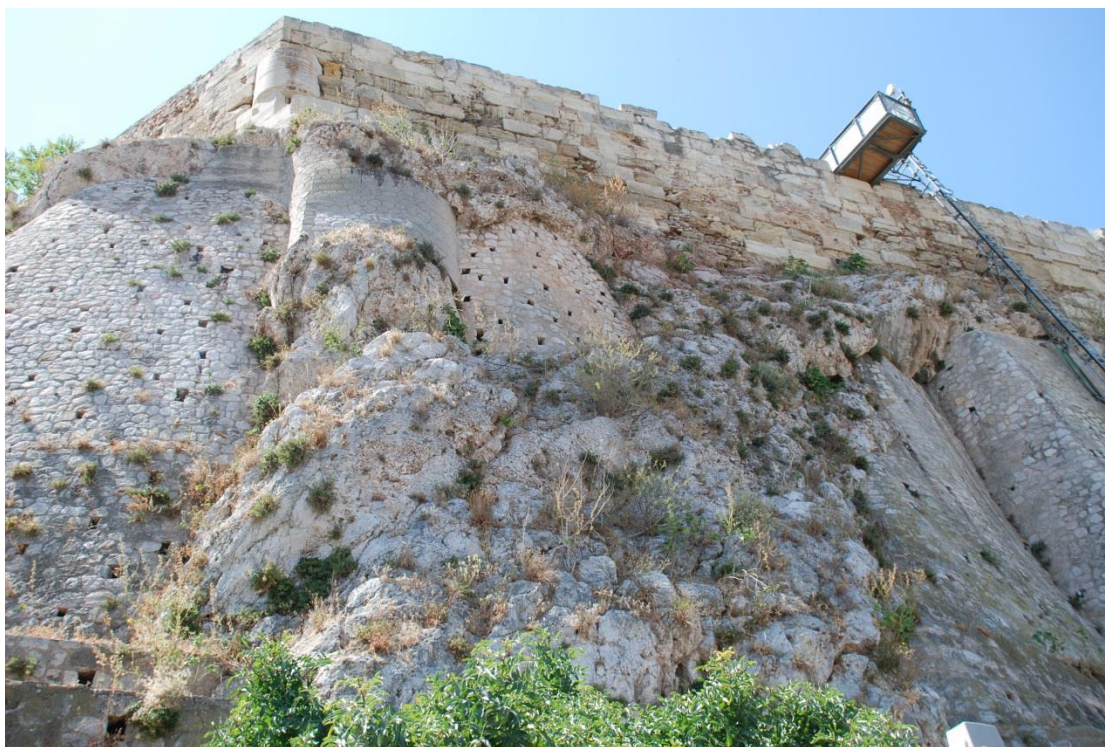
Εικ. 6 Άποψη Τείχους και βραχώδους πρανούς (βόρειο τμήμα, Μάιος 2016).
