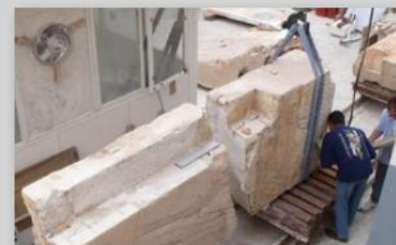
ΑΝΑΣΤΗΛΩΤΙΚΕΣ ΕΡΓΑΣΙΕΣ ΣΤΟΝ ΠΑΡΘΕΝΩΝΑ 8/05/2012
