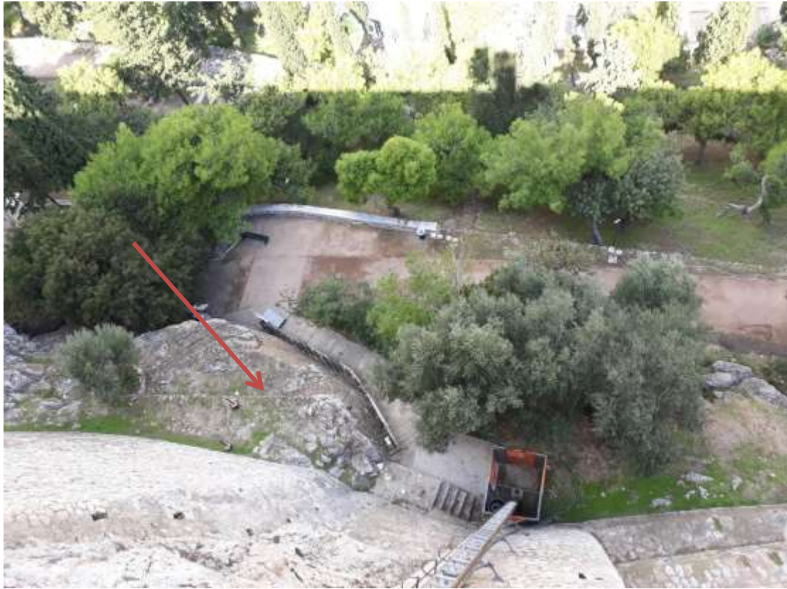
Εικ.4α. Ο χώρος πλησίον του ανελκυστήρα, όπου προβλέπεται να εδρασθεί το ικρίωμα και να διαμορφωθεί ο χώρος εργασίας
